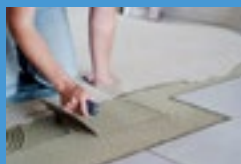
Fliesenlegearbeiten im Innen- und Außenbereich
