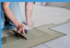
Fliesenlegearbeiten im Innen- und Außenbereich
