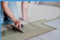
Fliesenlegearbeiten im Innen- und Außenbereich
